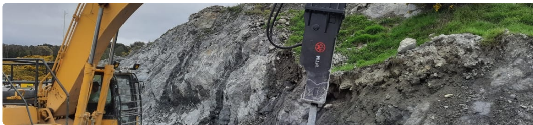
MTM-400 montado en excavadora, en faena de fractura de roca
