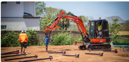
Perforación para fundaciones en obra residencial
