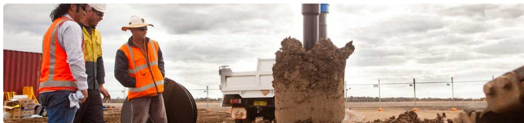
Ahoyador 25000 MAX montado en excavadora, en faena de perforación y extracción de terreno
