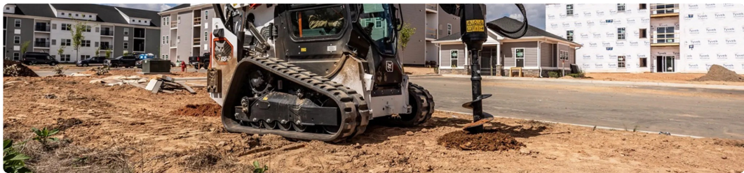
Bobcat T66 con ahoyador, perforando en obra residencial
